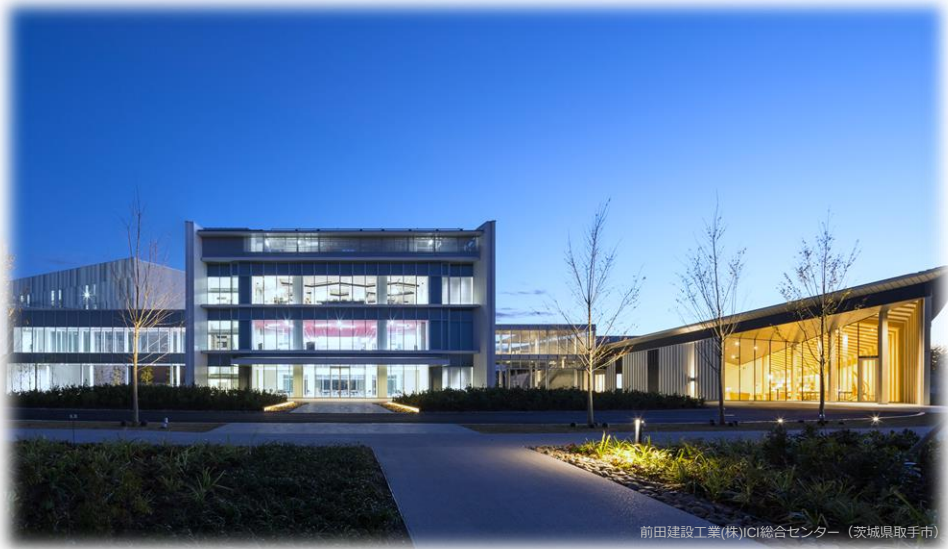
前田建設工業(株)ICI総合センター（茨城県取手市）
